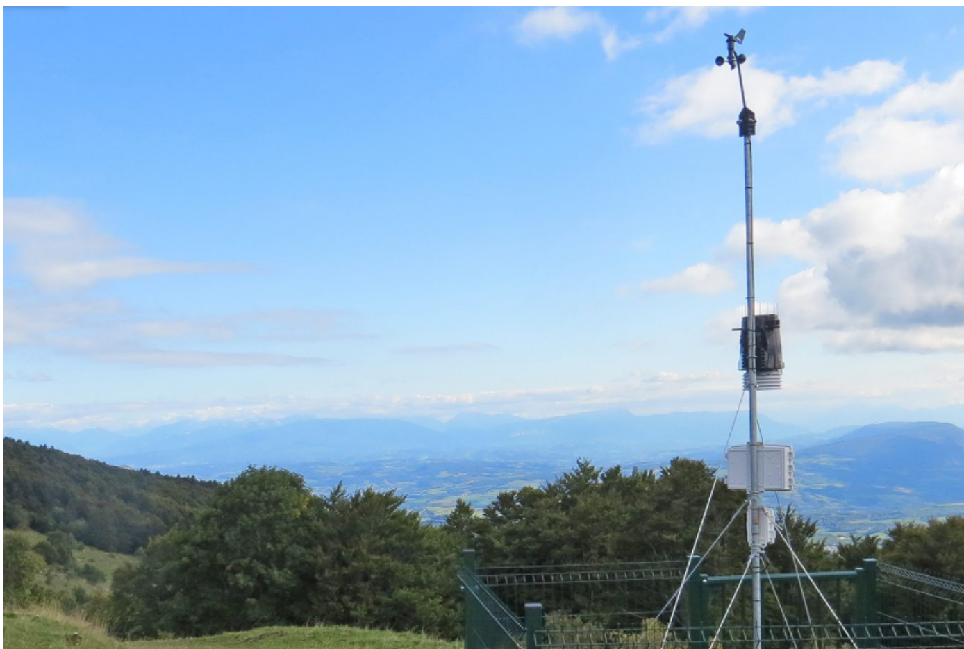
Station météo du Sorgia
